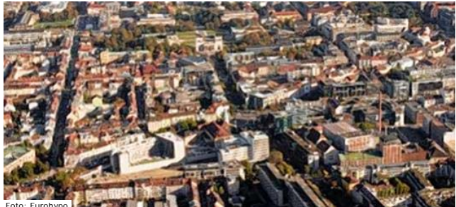
Foto: Eurohypo In der Innenstadt: Vorne links im Bild entsteht mit in den Nymphenburger Höfen zur Sandstraße hin attraktiver Wohnraum.
