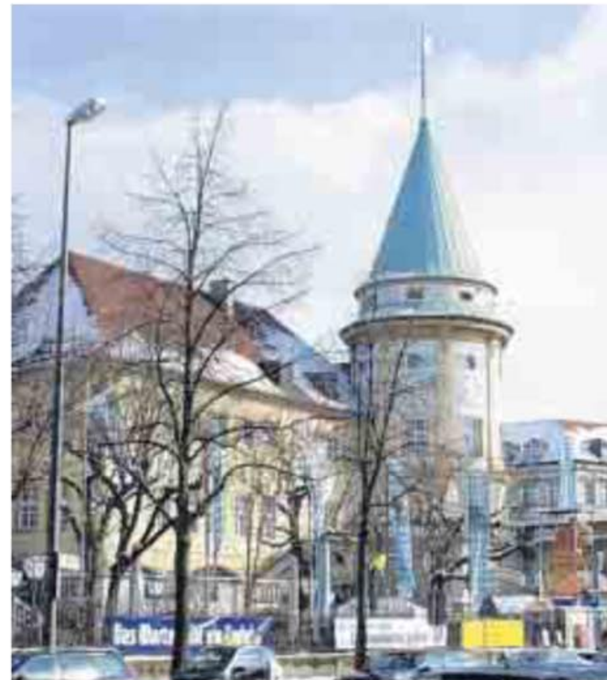
Auf dem Gelände des alten Löwenbräu an der Nymphenburger Straße entsteht ein neues Stadtquartier.
